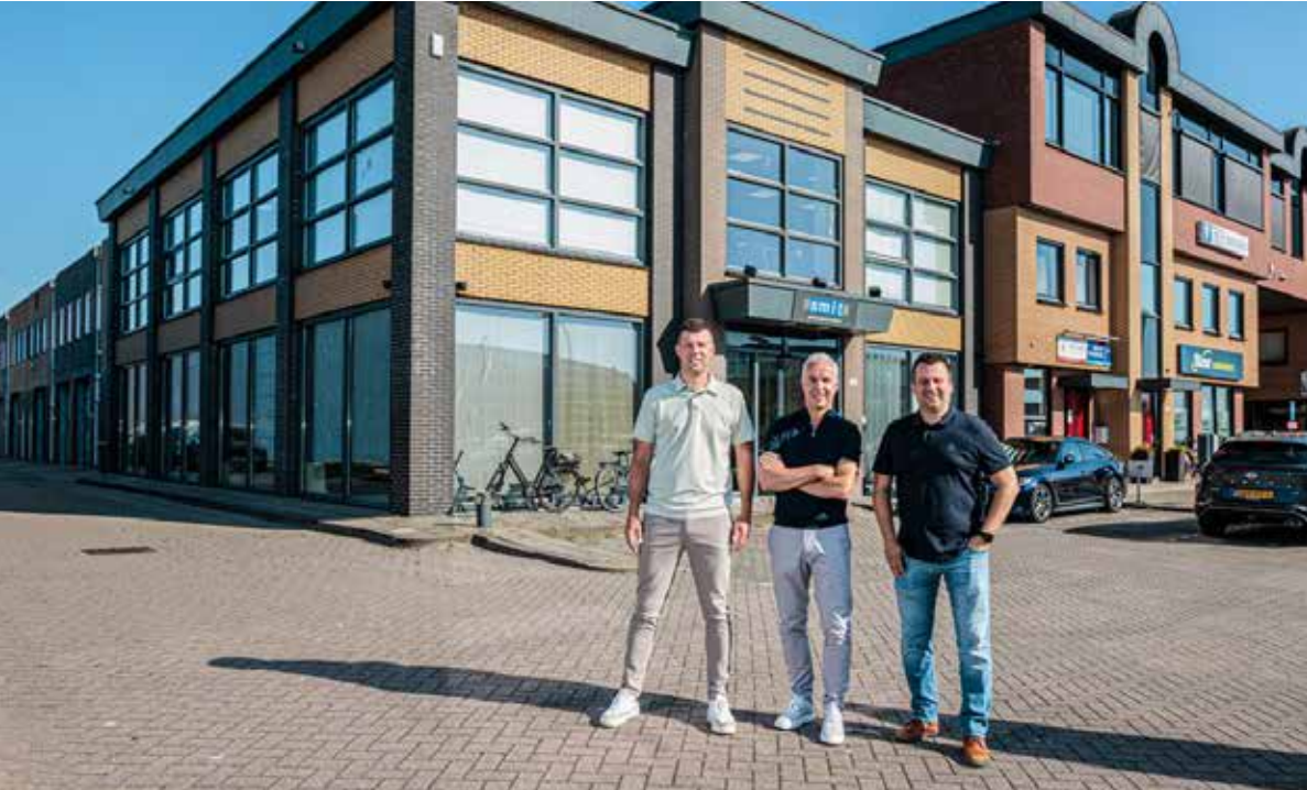
Tom Molenaar, Ron Plat en Frank Koning voor het volledig gerenoveerde pand aan de Julianaweg 139, het nieuwe thuis van Smit Beveiligingstechniek.
